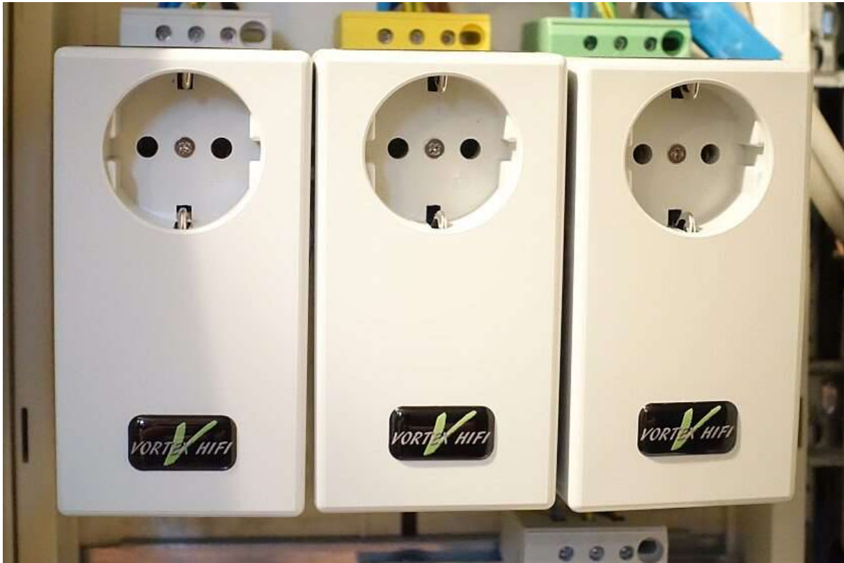
Für jede Phase einen PO2 MKII – Konsequente Entstörung fängt im Sicherungskasten an | Foto: FW
